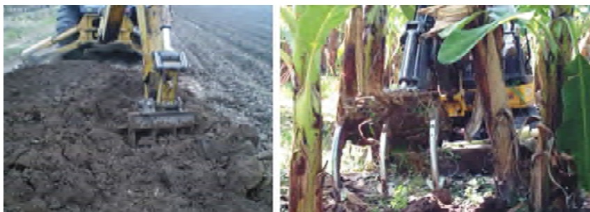
Foto 6. Retroexcavadora utilizada para subsuelo. El capacho original ha sido reemplazado por garras con punta.
