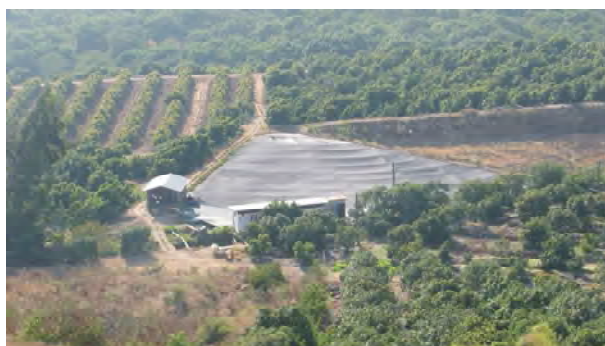
Foto 48. Uso de malla raschell para disminuir las pérdidas de evaporación desde el espejo de agua de un tranque.
