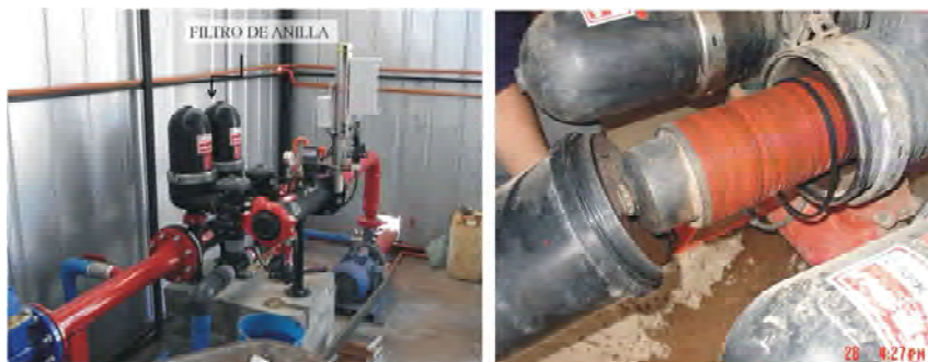
Foto 13. Cabezal de riego con filtro de anilla autolimpiable.
