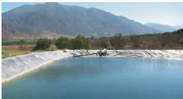
Foto 47. Lámina de PVC recubriendo paredes y fondo de un tranque para prevenir pérdidas por filtración.
