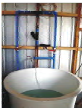
Foto 14. Inyector fertilizante Venturi.
