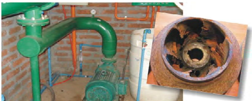
Foto 17. Rodete de una bomba centrífuga desgastado en forma prematura por el paso de fertilizantes y ácidos.
