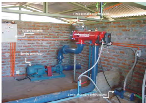
Foto 12a. Filtro de malla de retrolavado automático.
